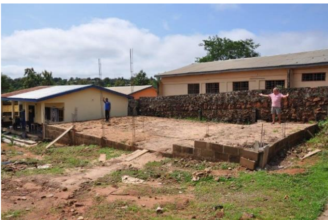
Fundering nieuwe Boys Dormitory
