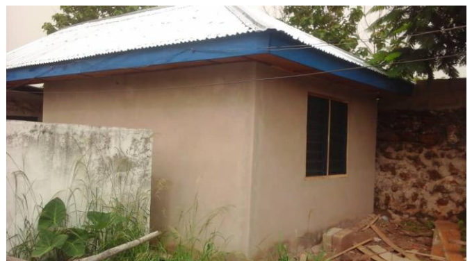
Het nieuwe "Kofi Asare" huis in aanbouw
